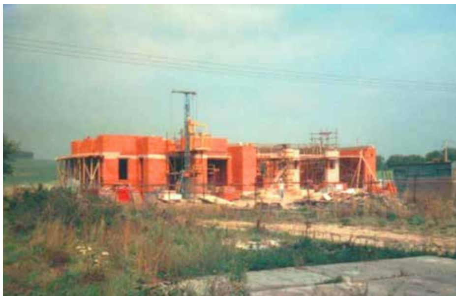
Výstavba stanice v roce 2000.
