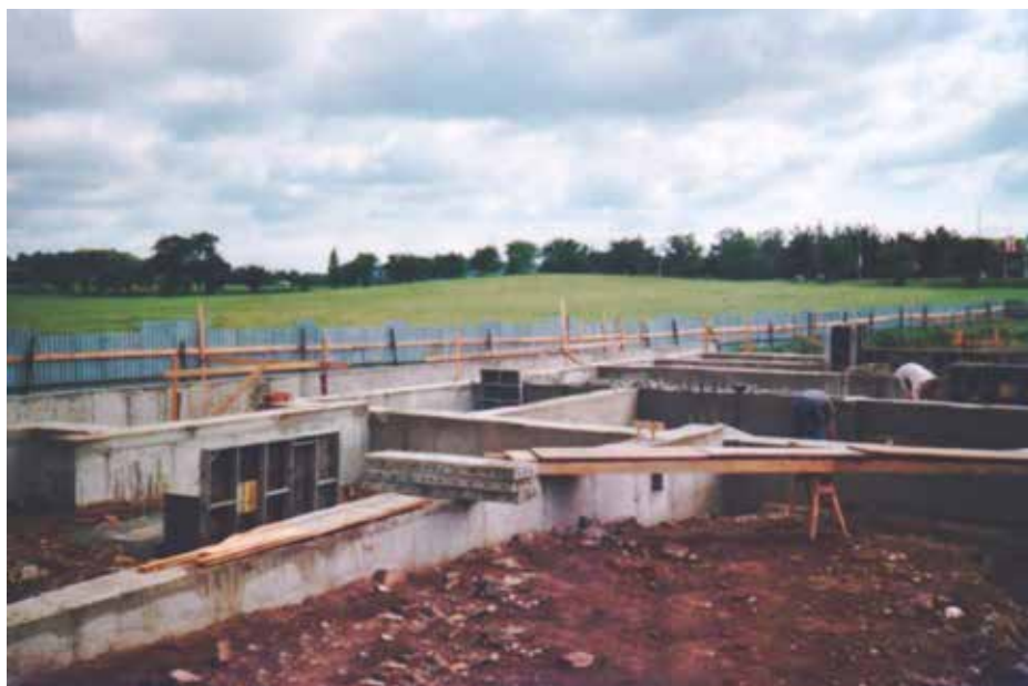
Výstavba stanice v roce 2000.
